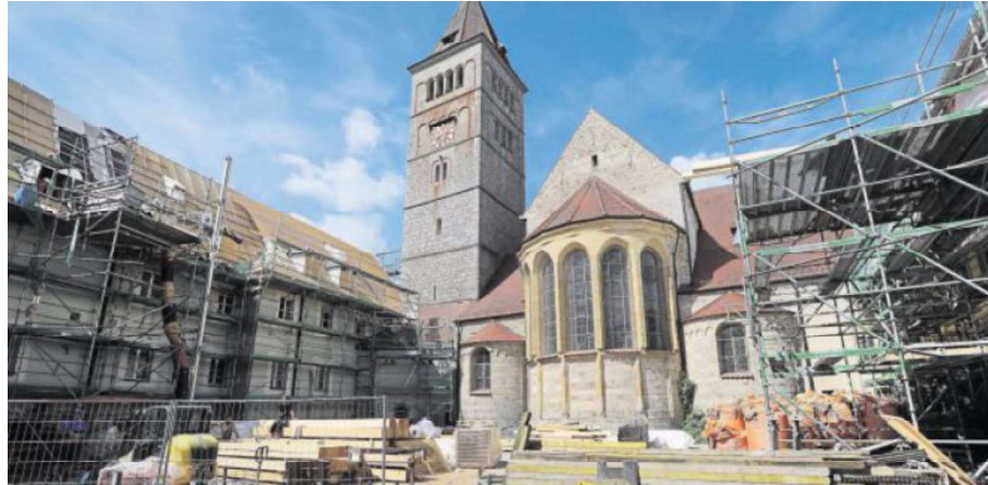
Stand der Bauarbeiten im Sommer 2019: Der Hof des Kastler Klosters diente als Lagerraum für die riesige Baustelle. Der Umbau des zuletzt als Ungarisches Gymnasium genutzten Gebäudekomplexes in eine Polizeihochschule für 120 Studenten kostet am Ende rund 60 Millionen Euro. Archivbild: Wolfgang Steinbacher
